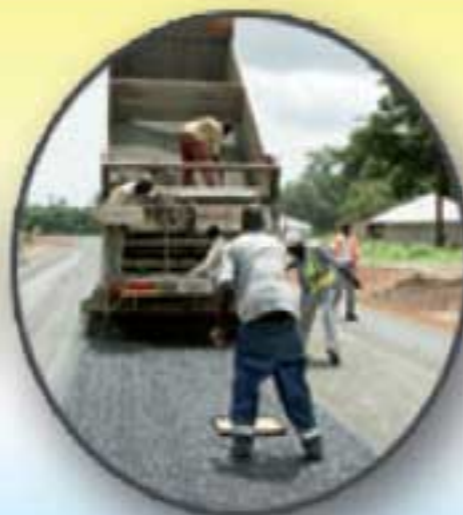
Aménagement de chaussées
